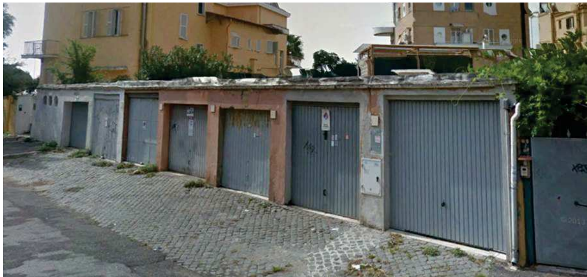
Figura 17 – Esempio di numerazione civica ai singoli box con accesso diretto su strada. Via Bocche di Bonifacio, Comune di Roma - Fonte Elaborazione su Google Earth
