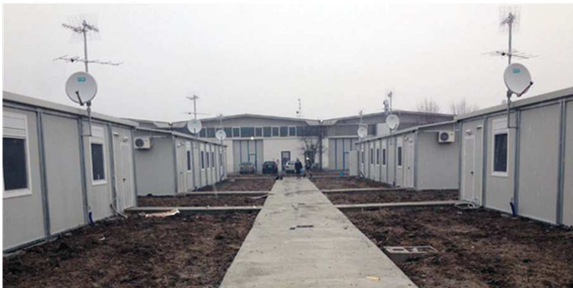
Figura 29 – Esempio di prefabbricati modulari abitativi rimovibili. Novi di Modena e Rovereto di Novi (MO)
